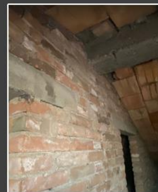
SOTTOSTRUTTURA IN LATERO CEMENTO
